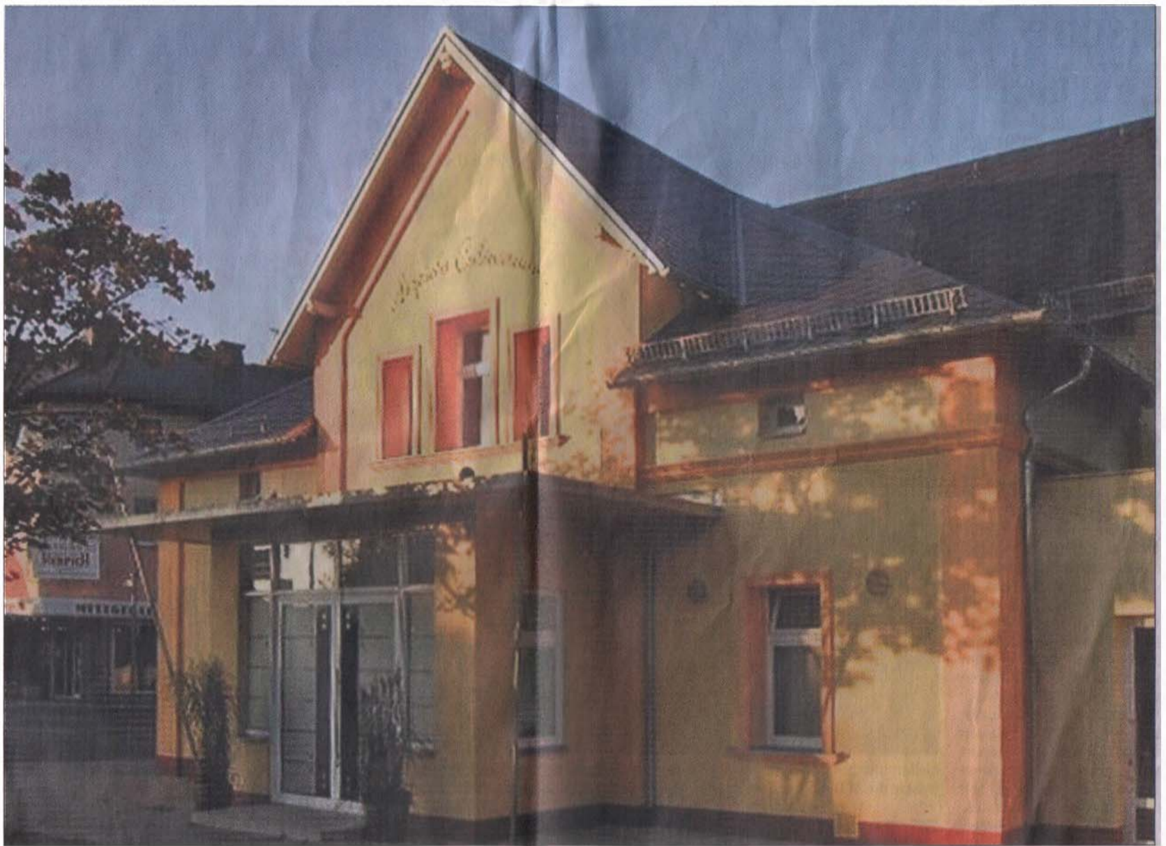
Eine gedämmte Fassade muss nicht einförmig glatt sein. Optische Gliederungen, ein interessant gestalteter Windfang, der leicht vorspringende Giebel und der zweifarbige Anstrich machen das Gebäude zum Blickfang. Foto: privat
